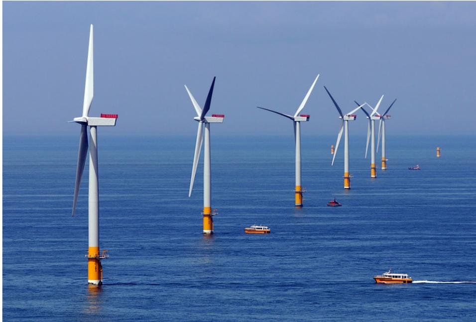
圖 1 英國北海 Greater Gabbard 風場中的單樁式離岸風機照片[SSE 2011]
